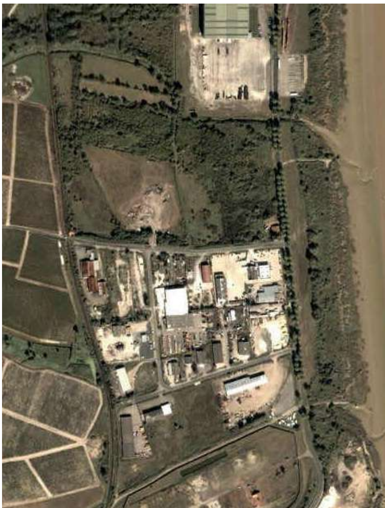
Vue aérienne de l'Etat Initial
